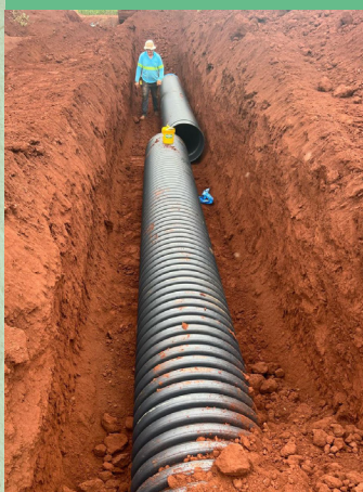
Aplicação de Tubos Corrugados Dupla Parede da Cimflex em obra
